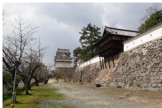
図 59 二之丸南側 現況
