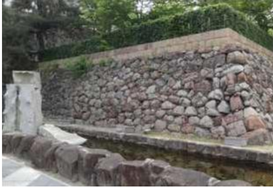
図 38 福山城跡東二之丸下段南側石垣に残る戦災跡 (石垣全面被熱し、築石の角が丸くなっている)
