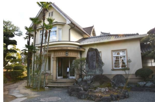
図 49 福寿会館 洋館
