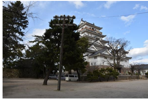
図 43 天守ライトアップ用の照明器
