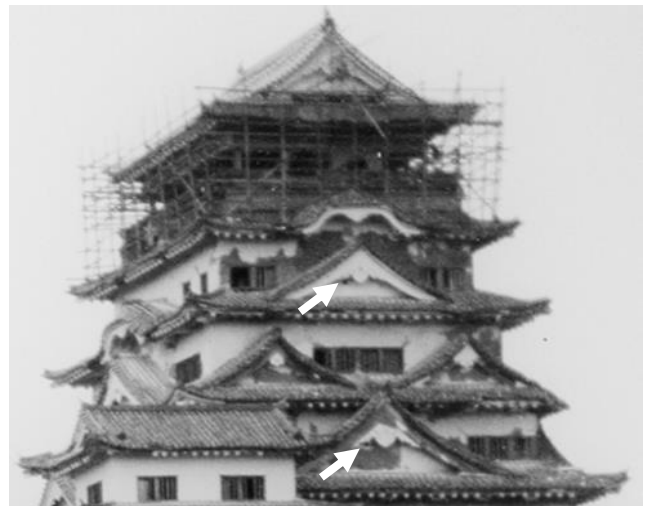
8 東面二層階中央及び四層階中央の鉄砲狭間
