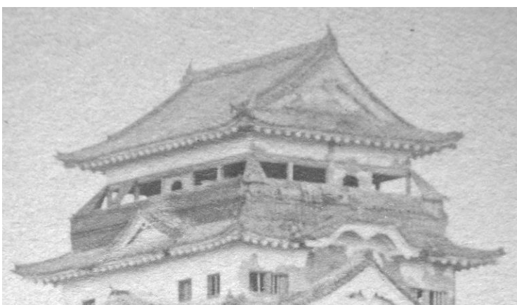
3 南面・東面の板戸をはずした状態(拡大) (南面奥に西面の窓が、東面奥に北面の窓が見える)
