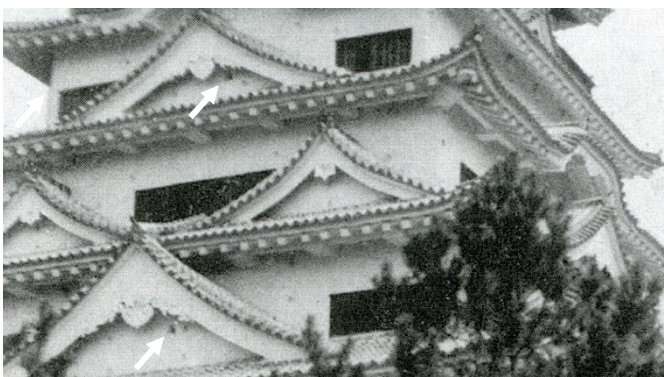
9 西面二層階中央及び四層階中央の鉄砲狭間
