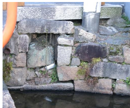
図 75 御手洗川に残る江戸時代の上水道取水口跡
