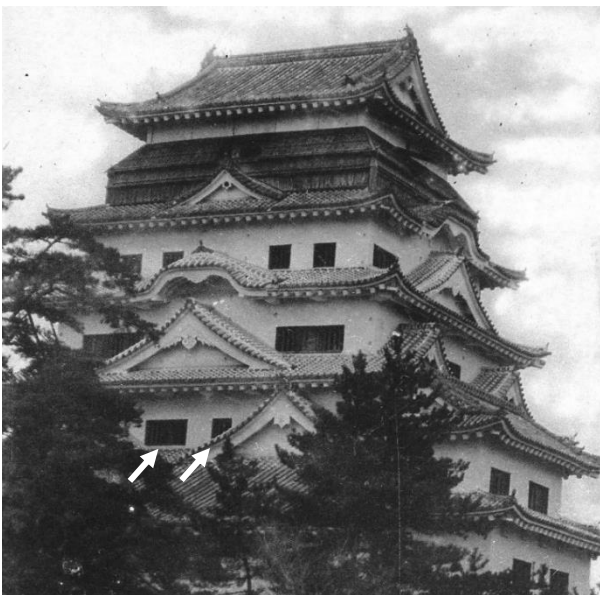
14 南面二層階の中央窓 (格子窓が2つに分かれている)
