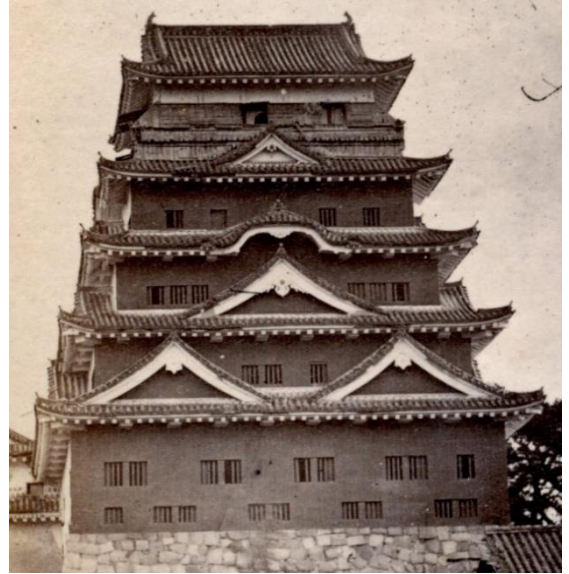
6 北面の鉄板張り全景
