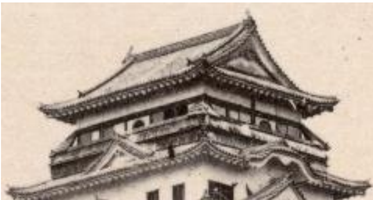
1 南面・東面の壁面状況(拡大)
