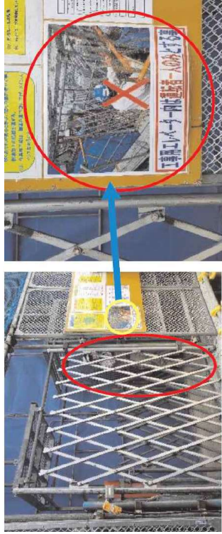
工事用エレベーターの定員を限定、ポスターを掲示
