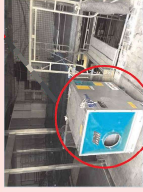
集塵機を設置し室内の換気を実施
