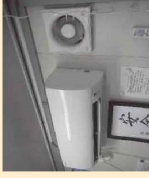
扇風機や換気扇とエアコンを併用
