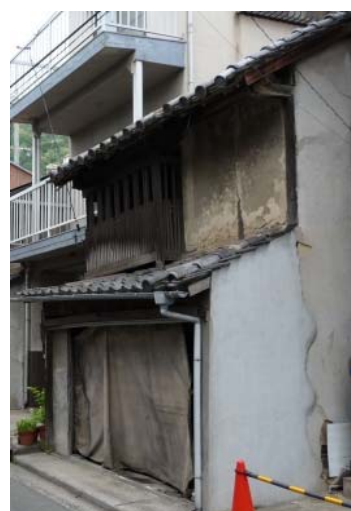
老朽化の著しい建物
