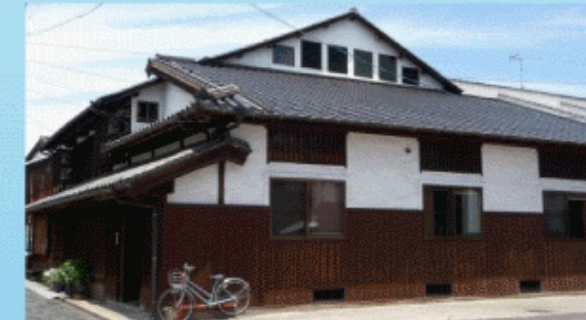
町家の活用事例 (高齢者向け地域密着型多機能ホーム)
