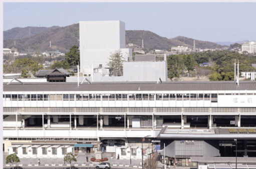
工事中の福山城の様子(2/10現在)
