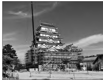
改修工事の始まった福山城
