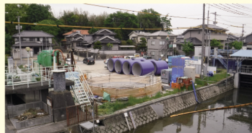
県:(仮称)福川排水機場の新設
