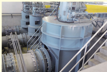
古市排水ポンプ場のポンプ増設
