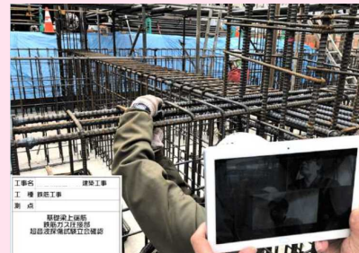
Webカメラを利用した遠隔検査
