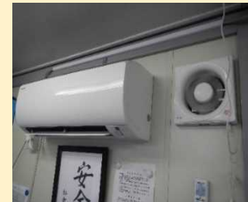
扇風機や換気扇とエアコンを併用
