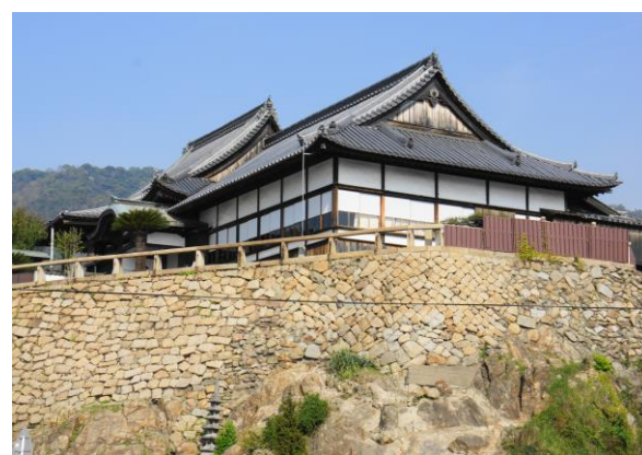
伝統的建造物(工作物)である福禅寺(対潮楼)の石垣
