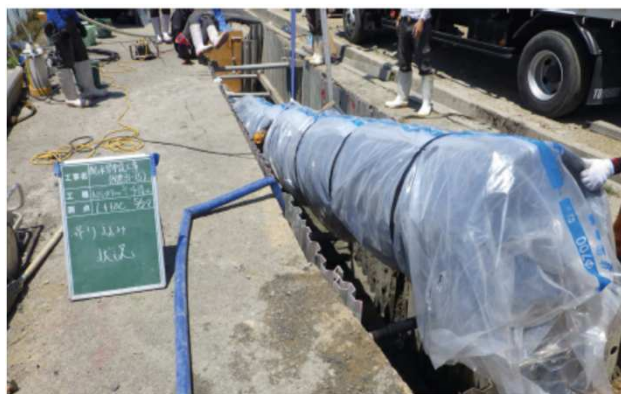
配水管布設工事
