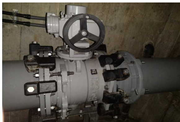
伊勢丘A配水池耐震補強工事
