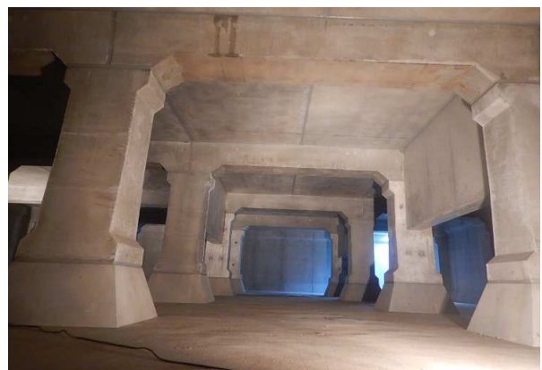
機織排水区雨水貯留施設築造工事(その2)
