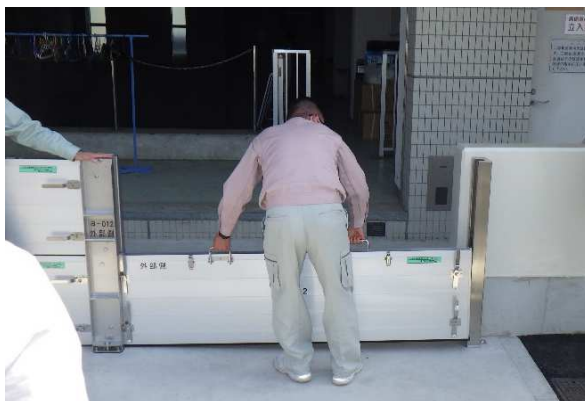
▲防水板を設置している様子
