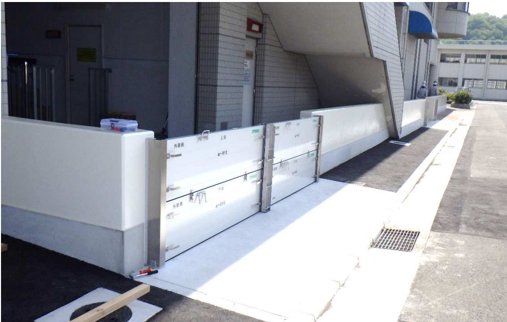
「中津原浄水場浸水対策」
