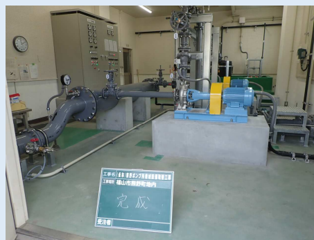
機械設備の更新後
