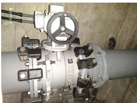
伊勢丘 A 配水池に設置している 緊急遮断弁 【2021 年度施工】
