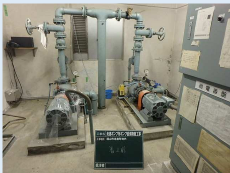
機械設備の更新前
