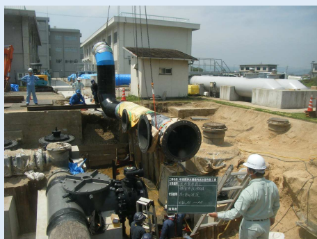
場内送水管の設置状況
