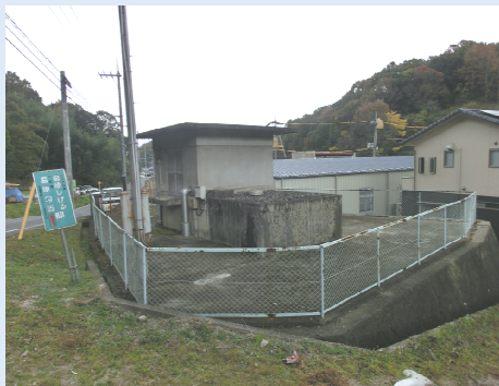
ポンプ室の更新前
