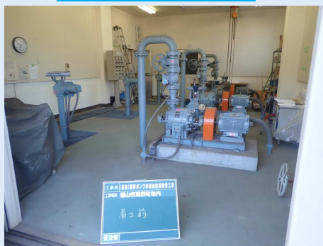
機械設備の更新前
