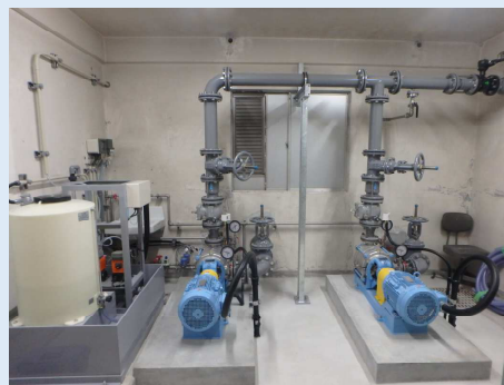
機械設備の更新後
