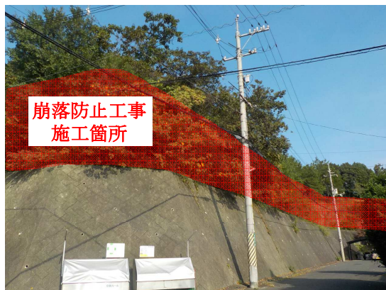
法面の下(住宅地側)から見た様子
