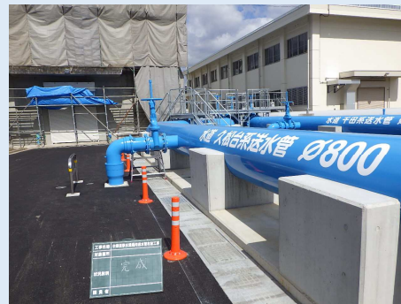
場内送水管の設置完了後
