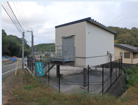
ポンプ室の更新後
