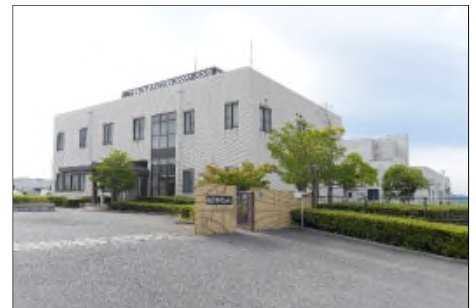
松永浄化センター
