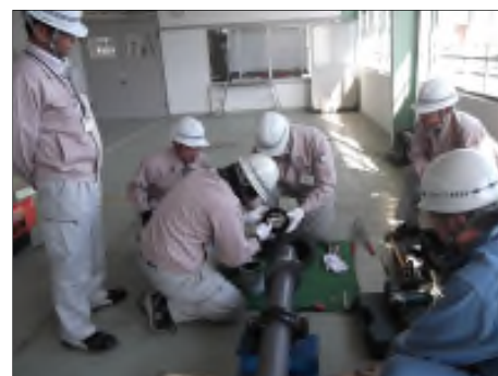
研修センターでの配水管接合研修
