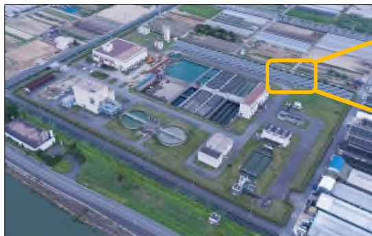
箕島浄水場での太陽光発電
