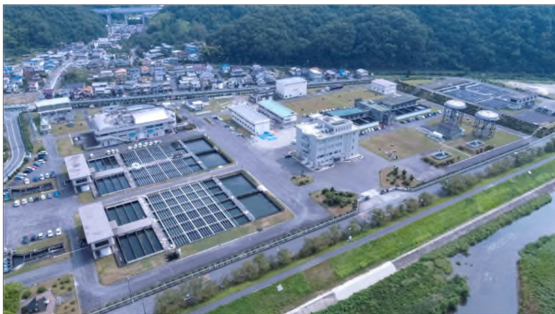
中津原浄水場 全景
