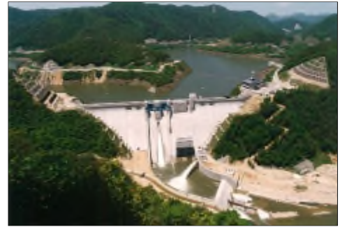
八田原ダム（八田原ダム管理所提供）
