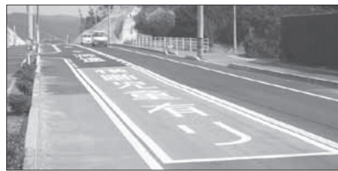
認識しやすい路面表示の取り組み(県道神辺大門線)
