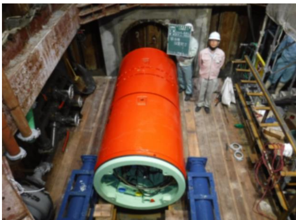
サヤ管推進工事(工水配改2-1)
