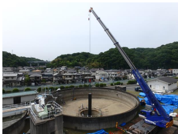
中津原浄水場濃縮設備取替工事
