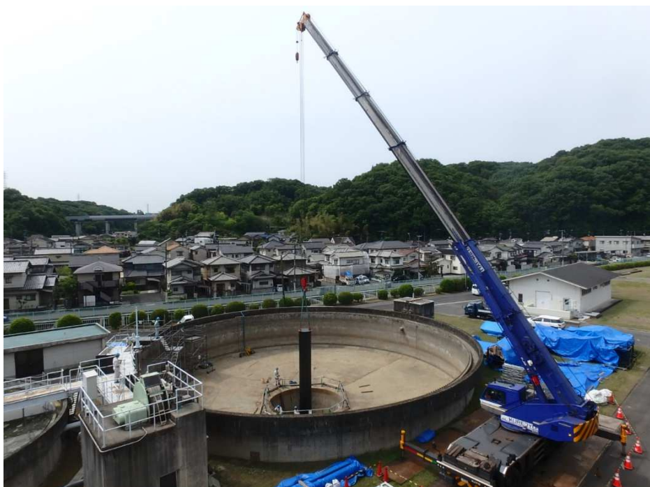
「中津原浄水場濃縮設備取替工事」
