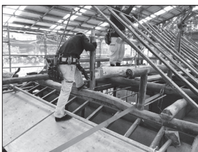
祠堂補修工事の様子
