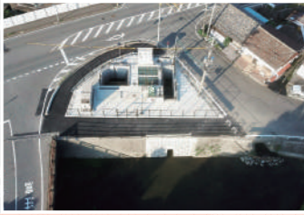
新たな排水機の整備(沼隈町)
