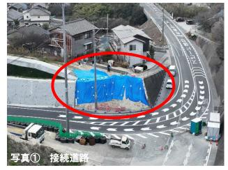
トンネル関係の工事はこれまで通行していた道路を埋める嵩上げ工事を行っています。 これまで、一番高いところで約6mの嵩上げを行いました。また、アクセス市道では清水川 の付け替えに伴い, 現況河川部分に排水管を設置し, 一旦盛土を行い, 土留矢板を設置 する工事に着手する予定です。
