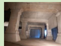
2021年度 雨水貯留施設 (松永中学校グラウンド地下)
