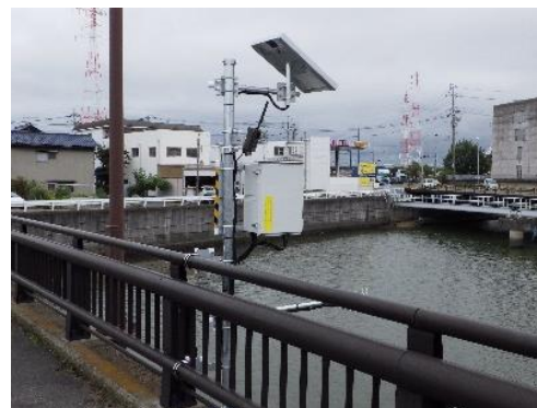
河川等状況監視システム
