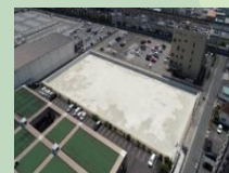
2020年度 雨水貯留施設 (東深津町)
