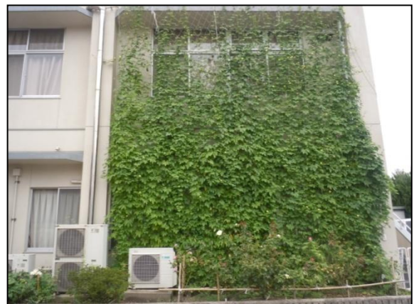
グリーンカーテン設置
