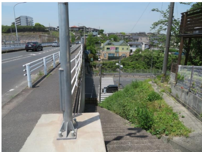
●陸橋の南東側にある階段
