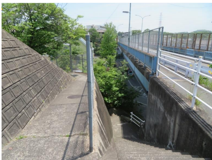
●陸橋の北東側にある階段
