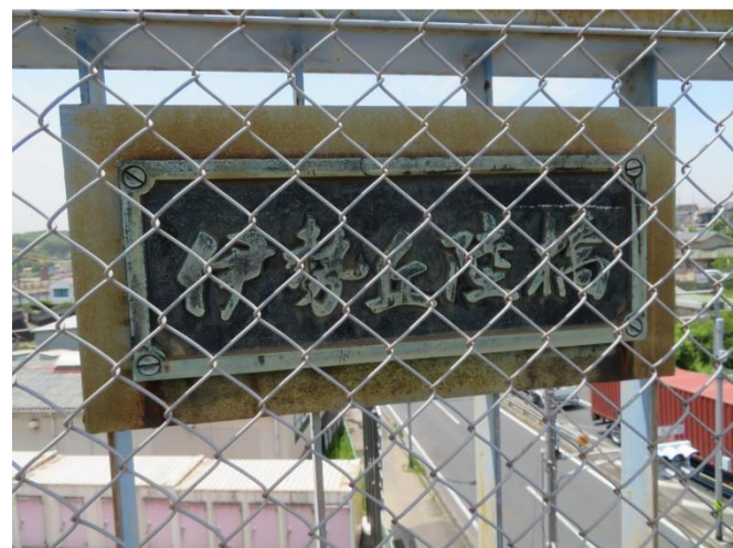
●陸橋の名を記すプレート
