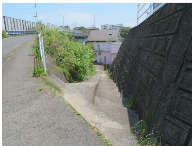
●陸橋の北西側にある階段
