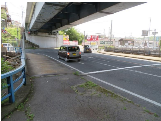
●陸橋の真下にかかる「引野橋」
