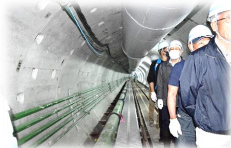
地中トンネルの中
