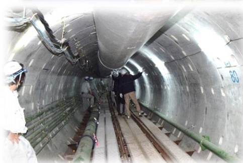
地中トンネルの中
