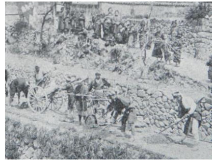
道路の補修工事（山手村）
