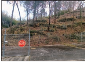
あしな台南側の伐採後の様子
