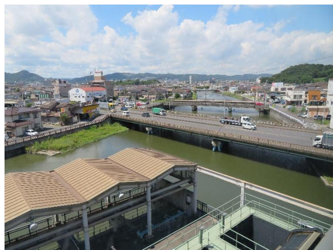
●排水機場から見た手城川
