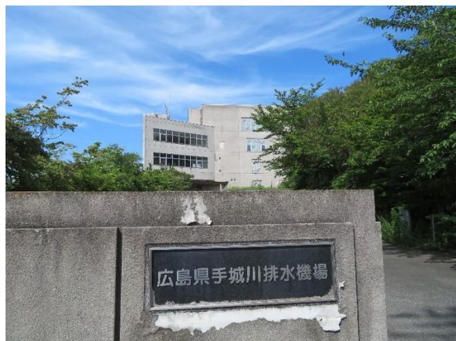
●手城川排水機場
