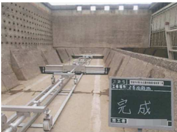
箕島浄水場2系沈澱池機械設備取替工事
