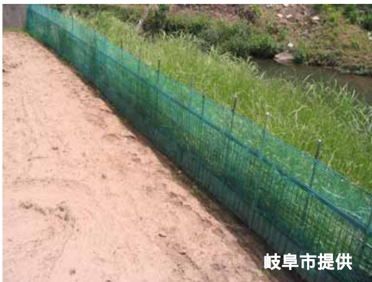
ネットと金属製メッシュ柵と波板を組み合わせた対策例
