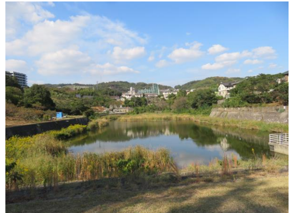
半田池土手から北側を望む
