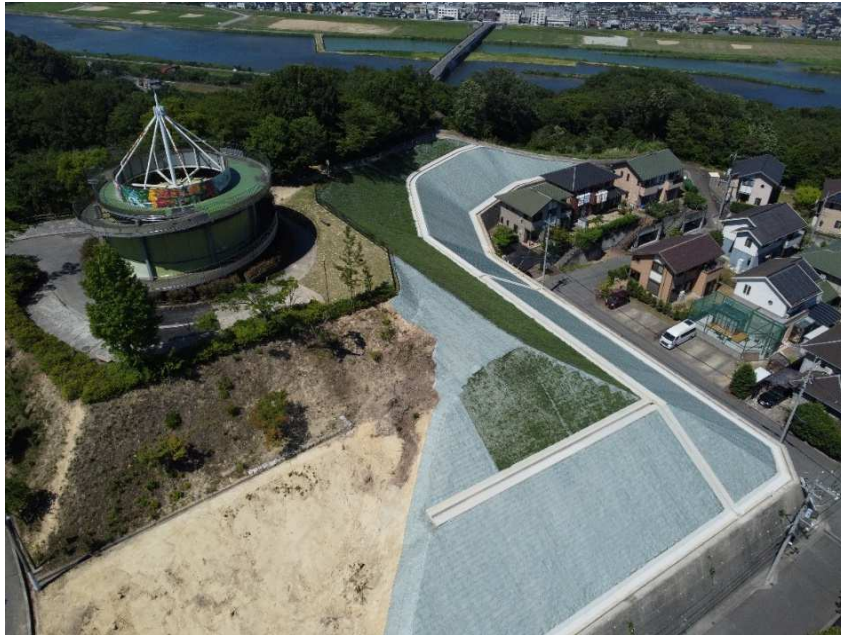
「明王台配水池法面崩壊対策工事」
