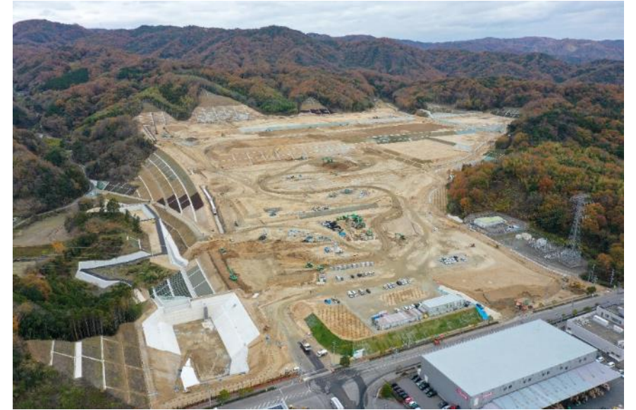
福山北産業団地第2期工事の様子
