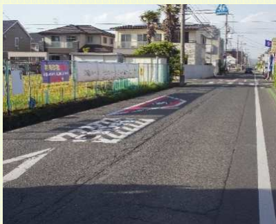
設置状況(概観)
