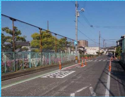
設置状況(概観)
