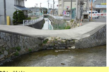
⑥越し井出 日本に2箇所しかないといわれている 川の氾濫を防ぐ為の井出
