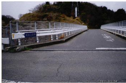
②高岩公園橋
