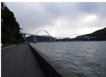
④内海大橋を見る
