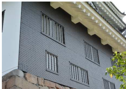
福山城天守北側の鉄板張り
