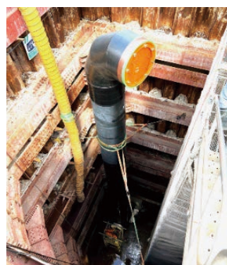
鋼管立上り部
