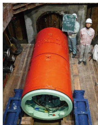
掘削機械(推進機)設置状況
