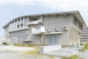
中央ポンプ場
