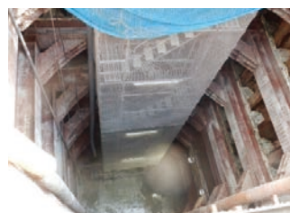
新浜町 発進立坑
