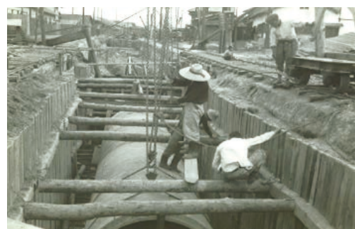
1953年(昭和28年) 下水道幹線の工事風景
