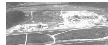
中津原浄水場の建設
