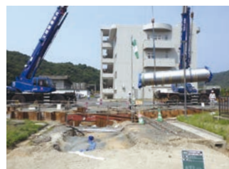
鋼管搬入状況
