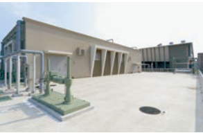
中央雨水滞水池
