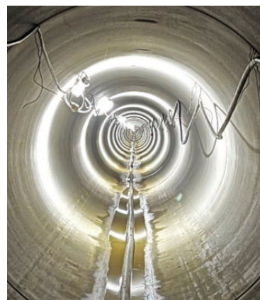
鉄筋コンクリート管内部
