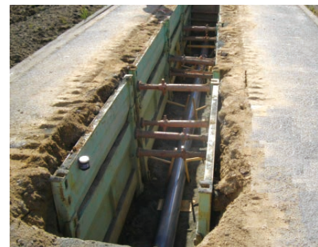
污水管渠施工状況(開削工法)
