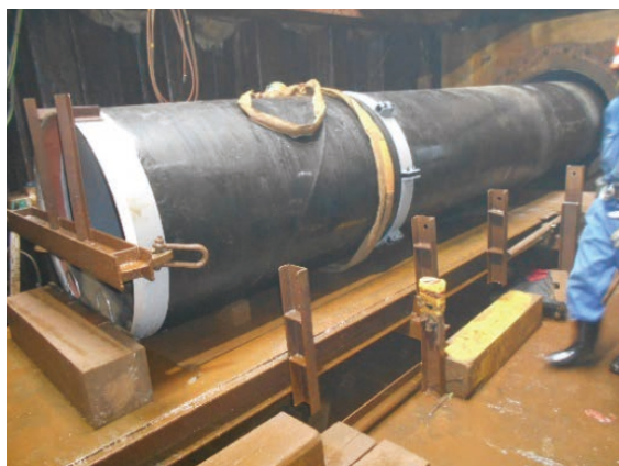
鋼管挿入状況
