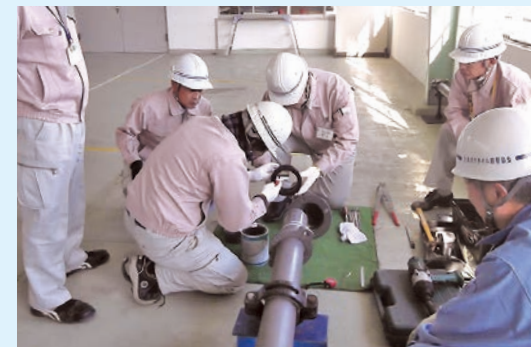
配水管接合研修
