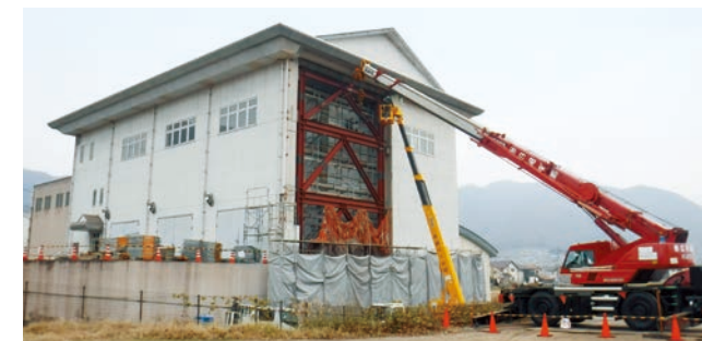
水呑ポンプ場の耐震補強工事
