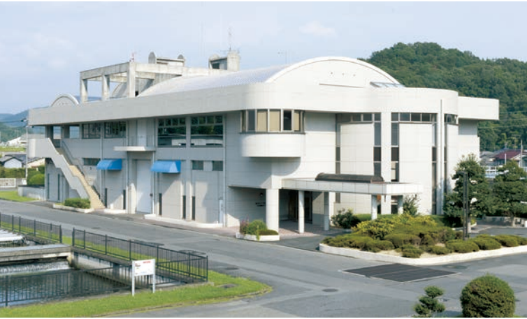
中央管理センター
