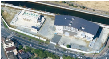
中央雨水滞水池(左)と中央ポンプ場(右)
