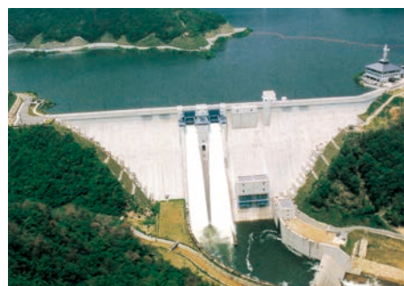
八田原ダム(八田原ダム管理所提供)
