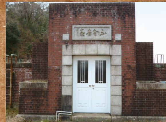
旧佐波浄水場 配水池
