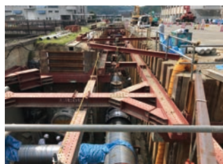
管路布設状況
