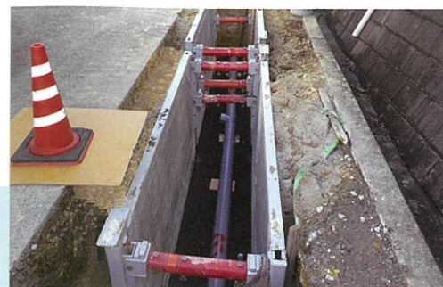
下水道管の工事
