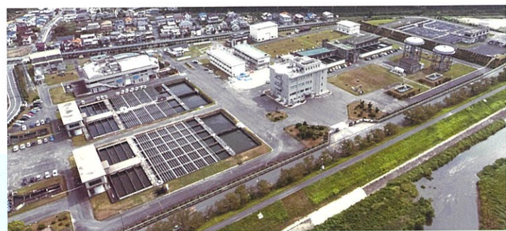
中津原浄水場
