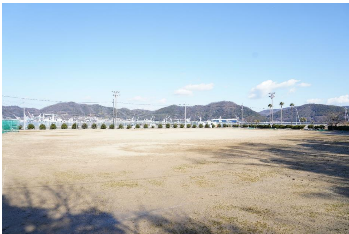
<屋外運動場、屋外運動場照明施設（東側の瀬戸内海を望む）>
