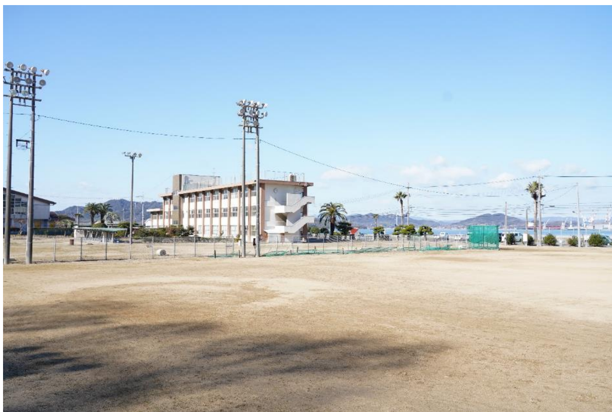
<屋外運動場、屋外運動場照明施設（西側の内海中学校を望む）>
