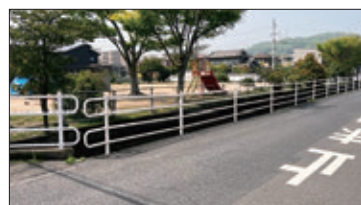
道路から水路への転落防止柵
