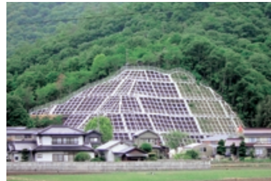
急傾斜地崩壊対策
