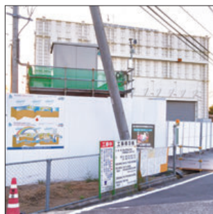
工事中の蔵王雨水幹線
