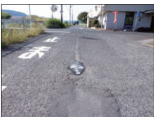
補修された市道
