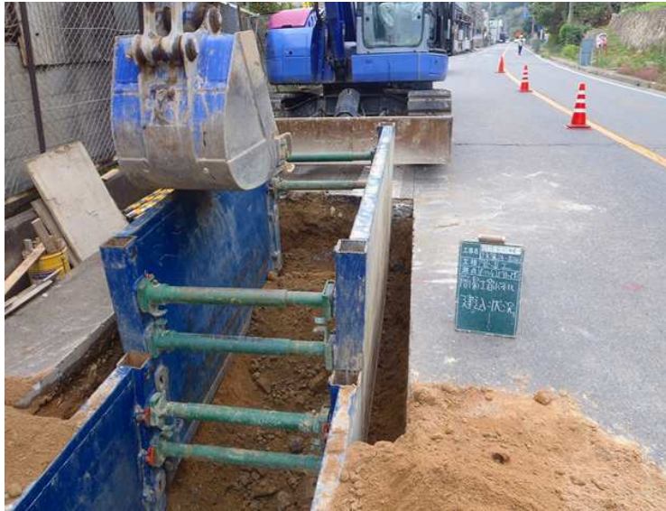
土留め設置状況
