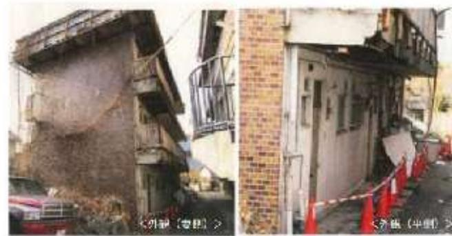
外壁、手すりが崩落した事例
