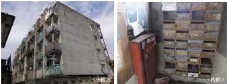
建物の傷みが著しく外壁の剥落、鉄骨の露出などが見られる事例
