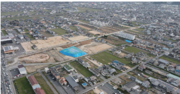
△ドローンで撮影した川南地区と建設中の道路の様子
