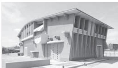
中央ポンプ場(東川口町)
