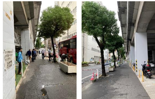
鉄道の高架が屋根代わりになっている様子
